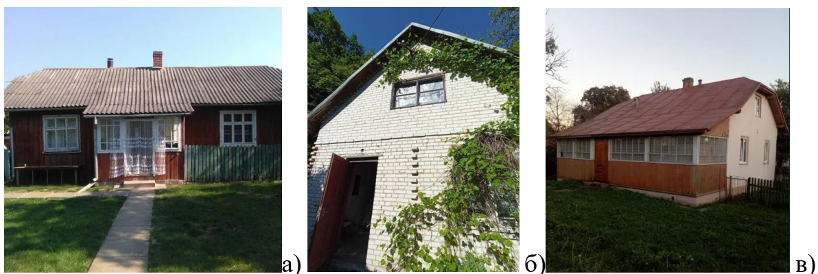
Рис. 17. а) будинок в селі Стенятин; б) житловий будинок у с. Страдч; в) житловий будинок у с. Биличі біля Самбора
