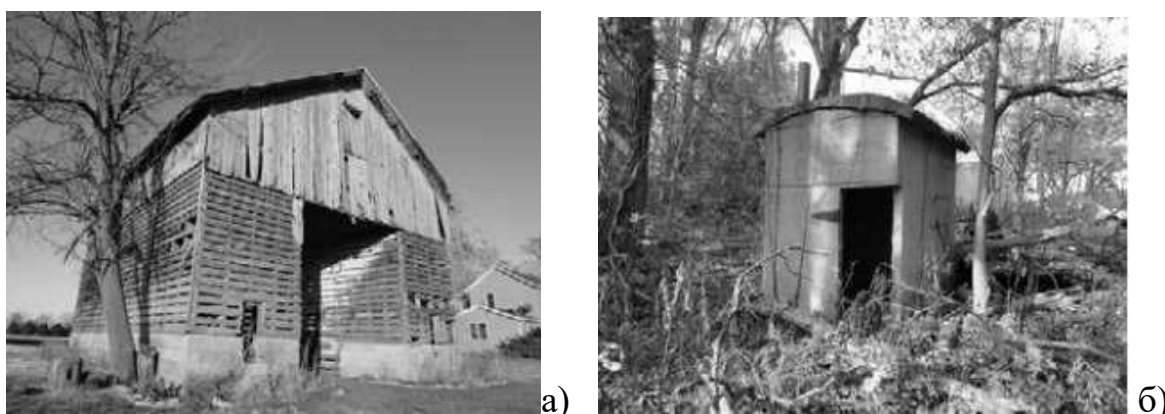
Рис. 36. а) криб-хлів на фермі Ганфорда з піднятим бетонним фундаментом; б) приклад цілковито бетонної споруди – схованки на фермі Джона Гудвіна [81, с. 39].
