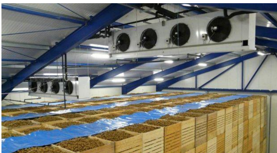
Рис. 5.2. Зберігання бульб картоплі у сховищі з інтенсивною загальнообмінною вентиляцією (джерело: https://abh.com.ua/?p=962 )
