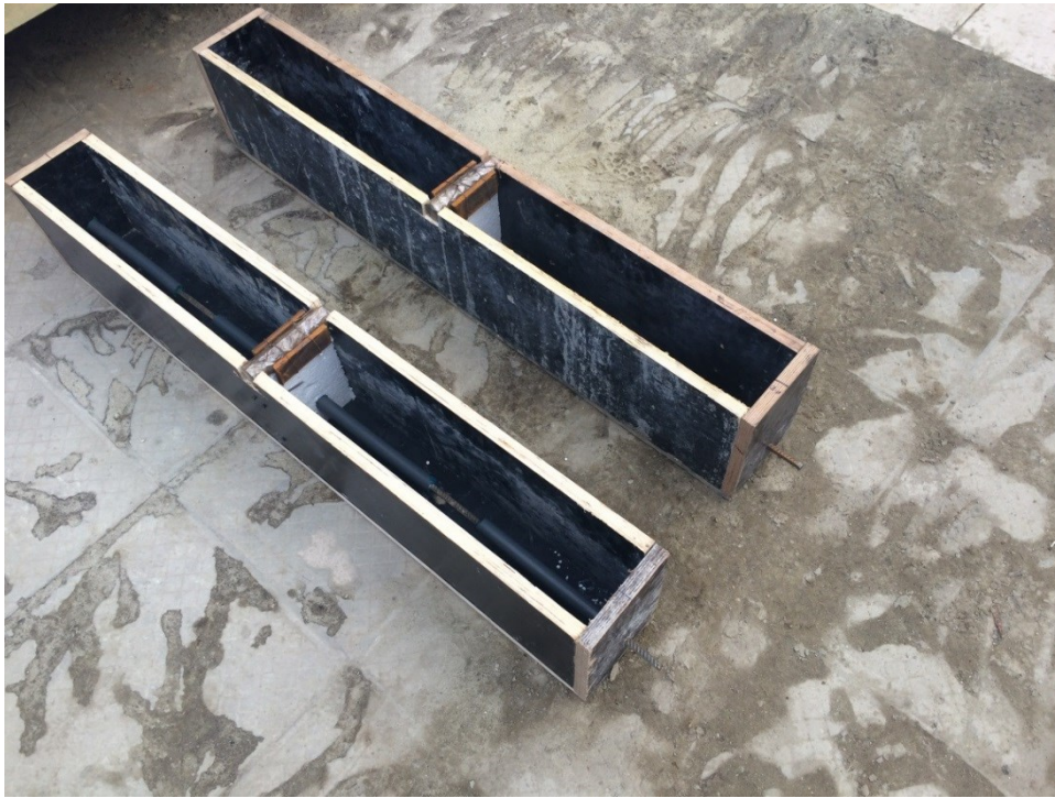
Рис. 2.7 – Опалубка підготовлена до бетонування
