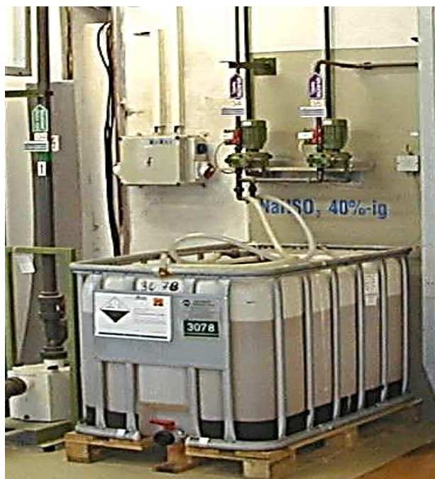
Рис. 3. Баки з готовими розчинами реагентів заводського виготовлення з трубопроводами та насосами-дозаторами (власне фото)
