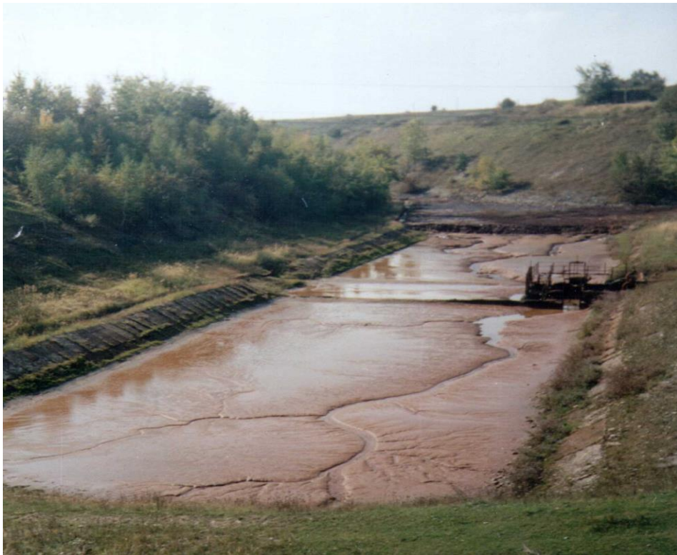
Рис. 3.4. Водозбірник №1 у дренажній траншеї
