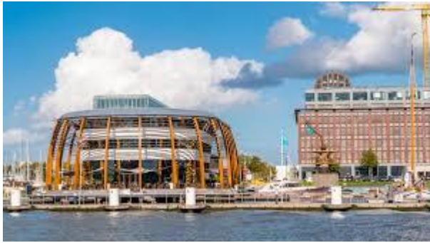
(Рис. 2.15 — Пішохідні простори ревіталізованої промзони, Жешув, Польща)
