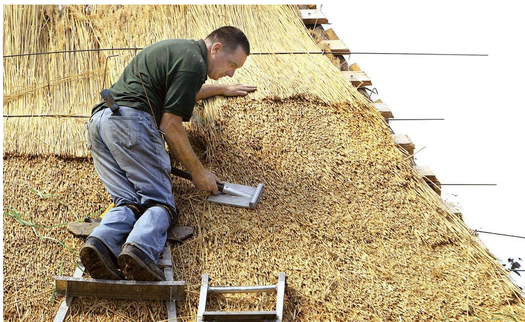
Рис 39. Процес укладання очеретяного настилу.
