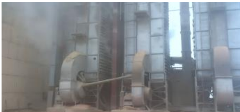
Рис. 2.4 – Система аспірації повітря (пиловловлювачі)
