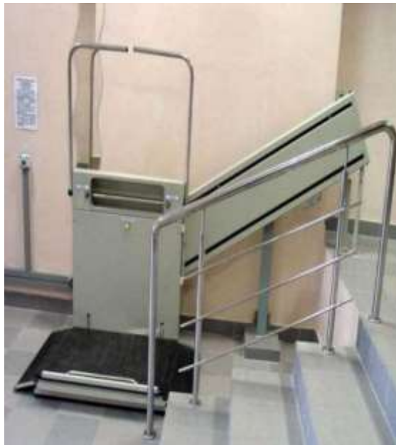
Рисунок 2.1 – Вертикальна підйомна платформа для переміщення користувачів крісел-колясок між рівнями будівлі
