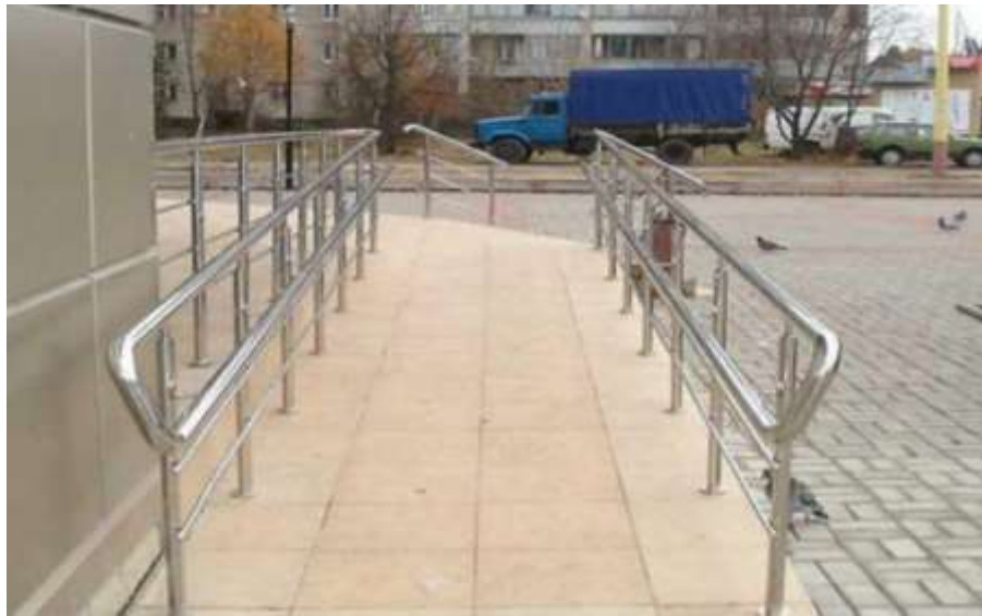
Рисунок 1.5 – Пандус з поручнями розташованими на відстані 1500 мм
