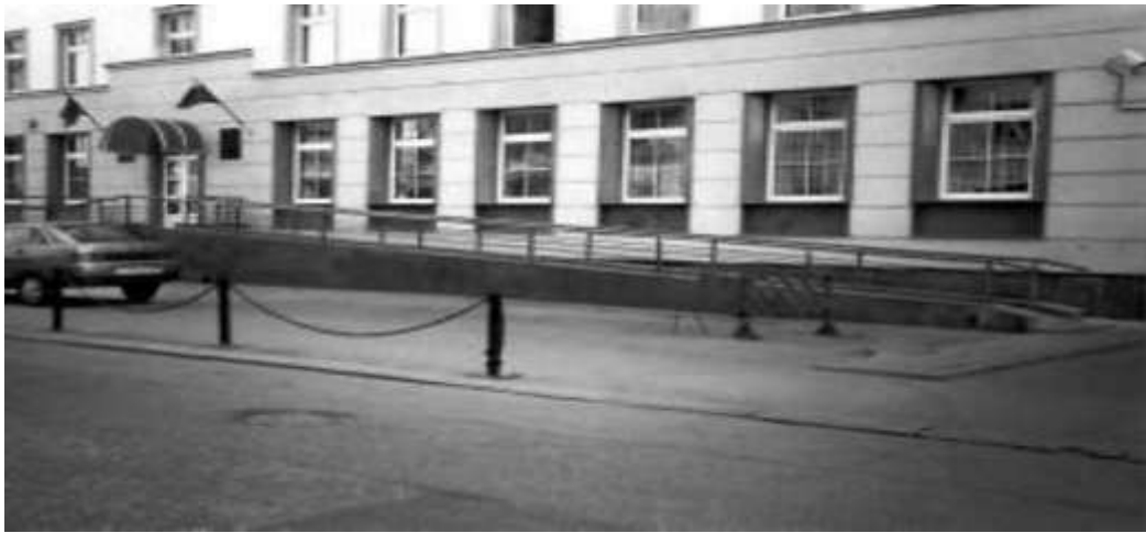
Рисунок 1.3 - Пандус, який відповідає будівельним нормам
