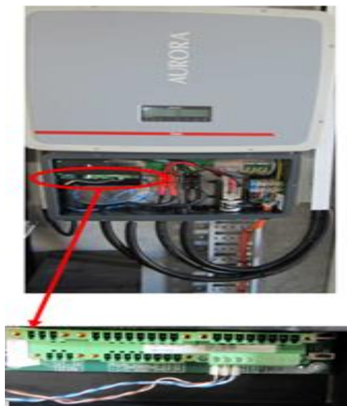
Рисунок 3.11 – Інвертор Power-One і з'єднання між Solar Gate та інвертором
