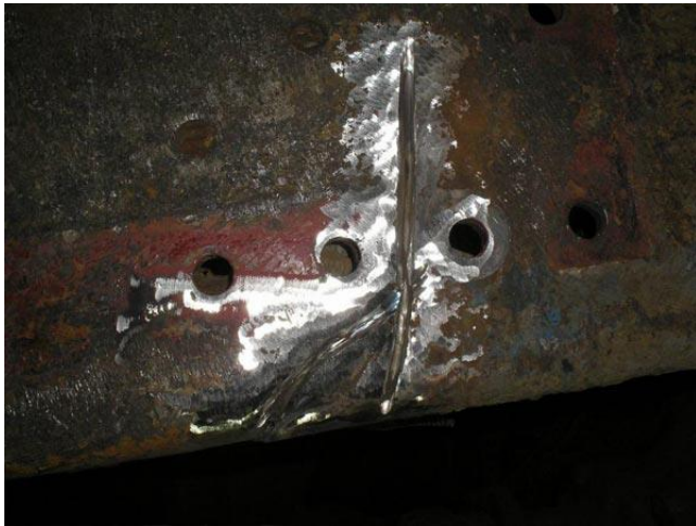
Рисунок 3.11 – Підготовка тріщини під зварювання
