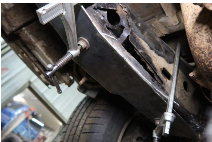
Рисунок 3.12 – застосування зварювальної оснастки для складання елементів рами під зварювання
