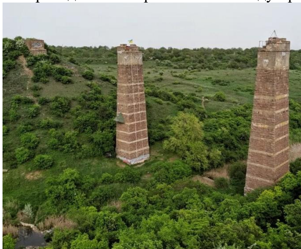
Колишній залізничний міст через балку Північну Червону. Фото Е. Дворчука
