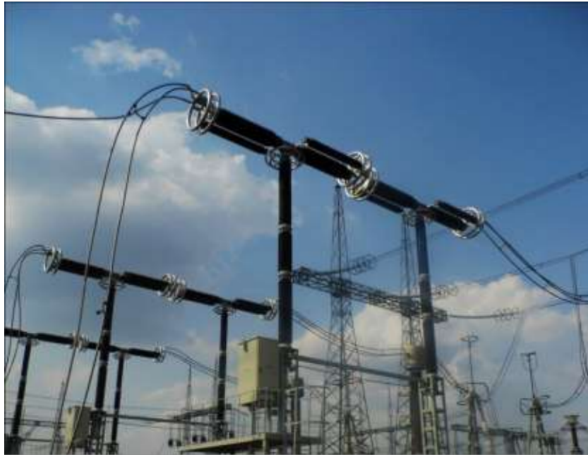
Рисунок 2.1 – Загальний вигляд вимикача АВВ типу LTV 362–800 (Т) Е4
