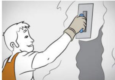
Рис. 3.14. Перетягування стіни
