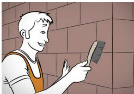
Рис. 3.1. Очищення поверхні стіни
