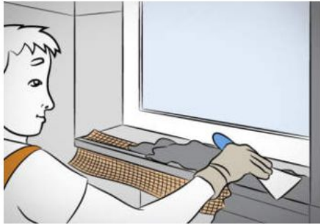
Рис. 3.11. Влаштування кутників на кутах для виведення рівних кутів
