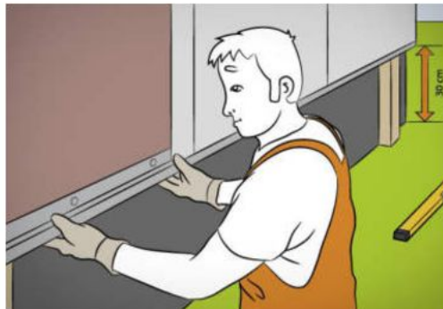
Рис. 3.2. Встановлення стартової планки
