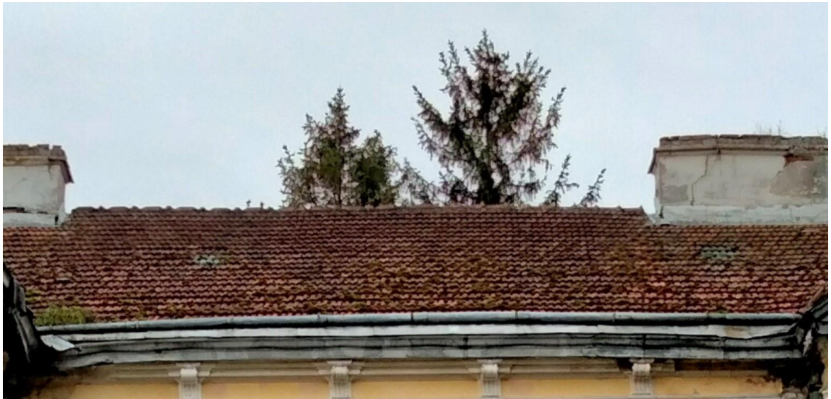
Рис.3.9 – Пошкодження покрівлі
