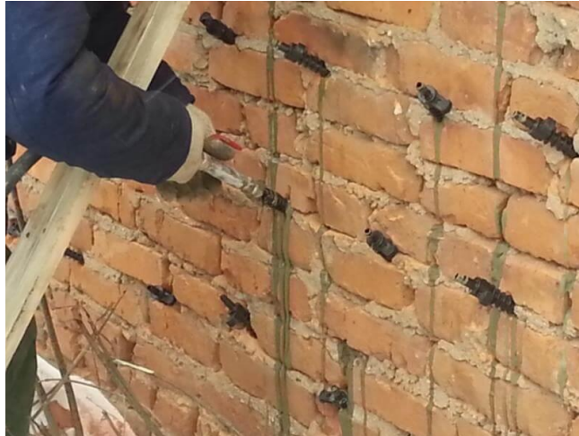
Рис. 3.6 – Процес нагнітання поліуретанової суміші
