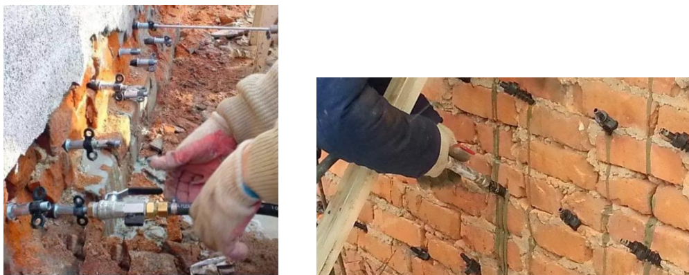
Рис. 7.13. Ін'єктування тріщин в кладці.
