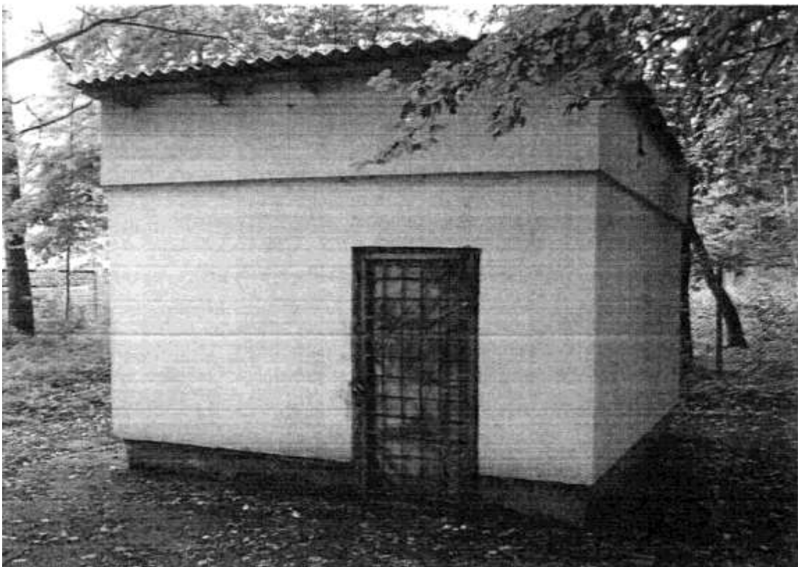
Рис. 4. Насосна станція надземного типу над свердловиною № 1
