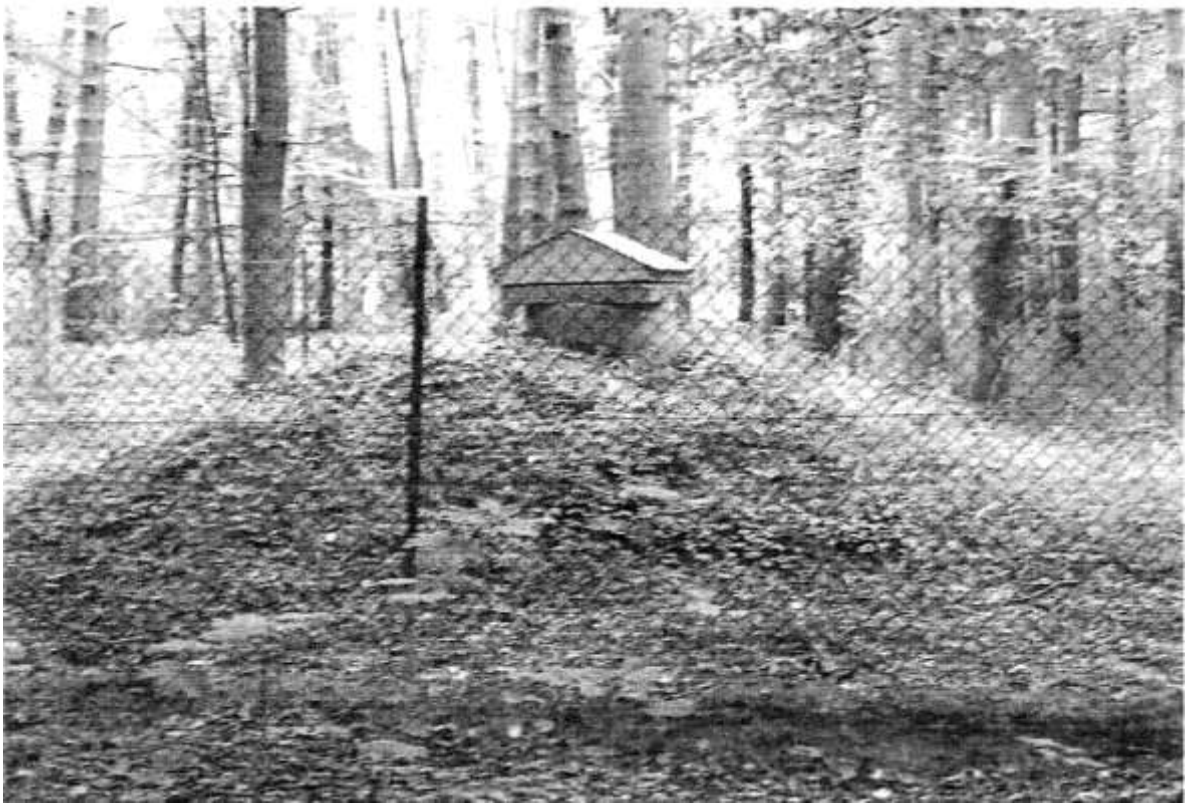
Рис. 6. Насосна станція підземного типу над свердловиною № 2
