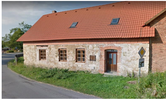
Рис. 16. - Житлова будівля з оголеним фасадом (Чехія)
