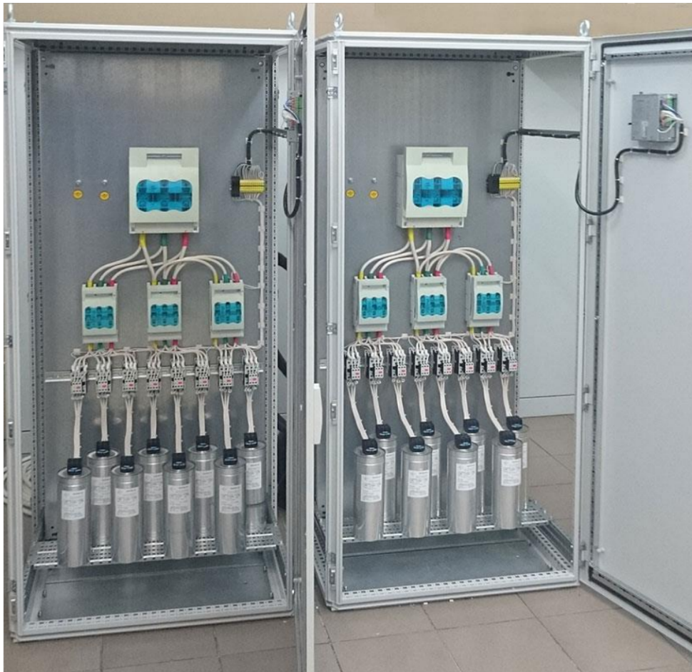
Рисунок 1.6 – Зовнішній вигляд установки поперечної компенсації [15]
