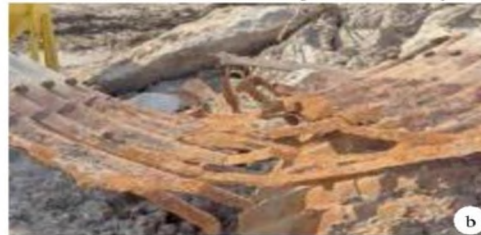
Рис. 6. Корозійні пошкодження металевих гофрованих конструкцій: а – корозія металу труби у процесі експлуатації; б – наскрізна корозія металу труби
