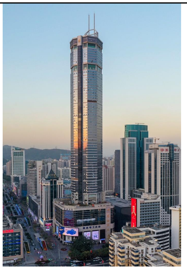
Рис. 6.3 Будівля 72-х поверхового торгово-адміністративного будинку
