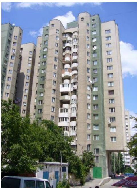
Рис. 6.1 Монолітна будівля з підрізкою нижніх поверхів
