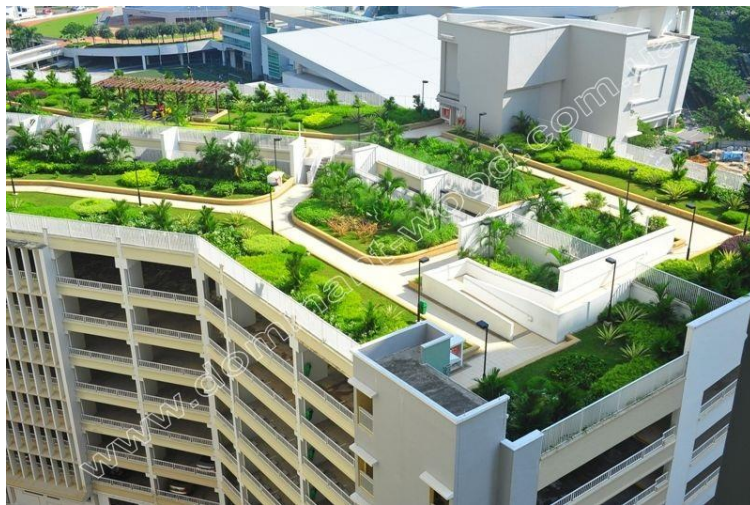
Рис. 6.2 Загальний вигляд зелених покрівель
