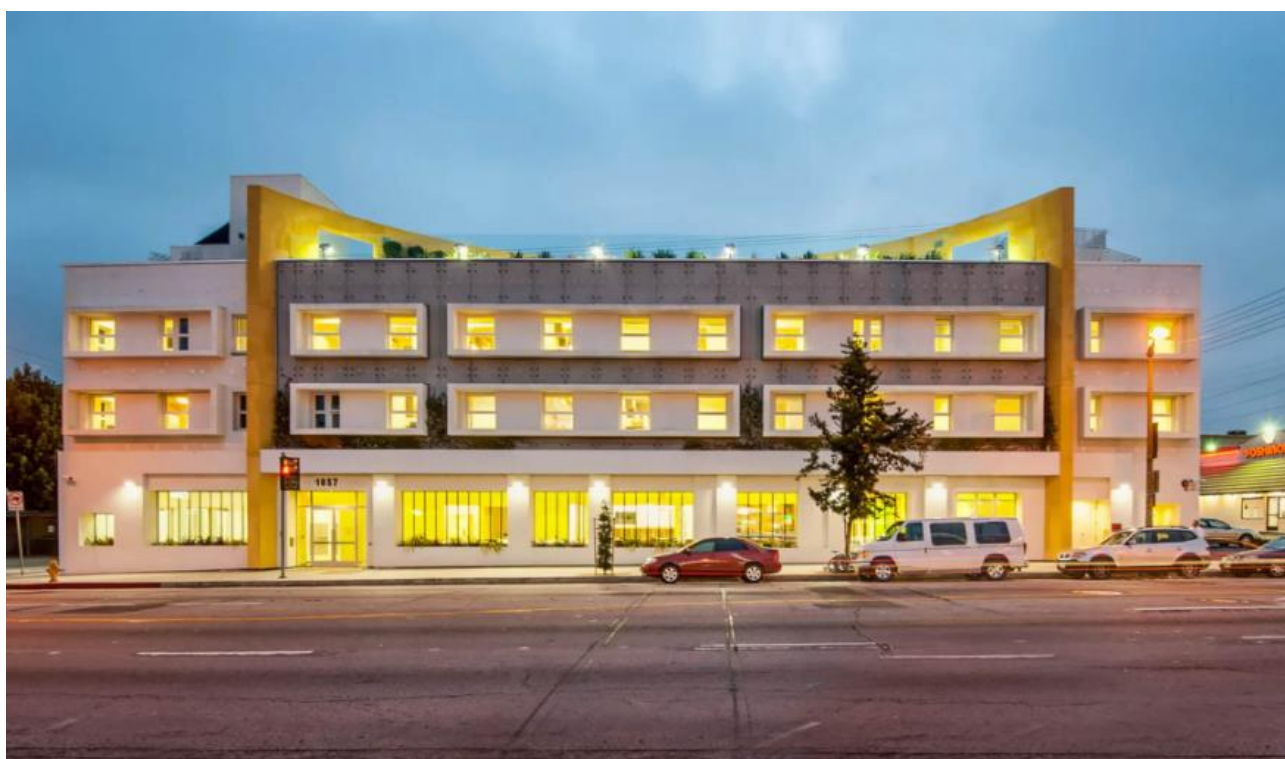
Рис. 28. – Котедж «Step Up On Vine» Culver City in L.A. America.
