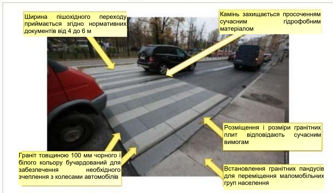
Рисунок 2.12 – Технологія виконання піднятих переходів
