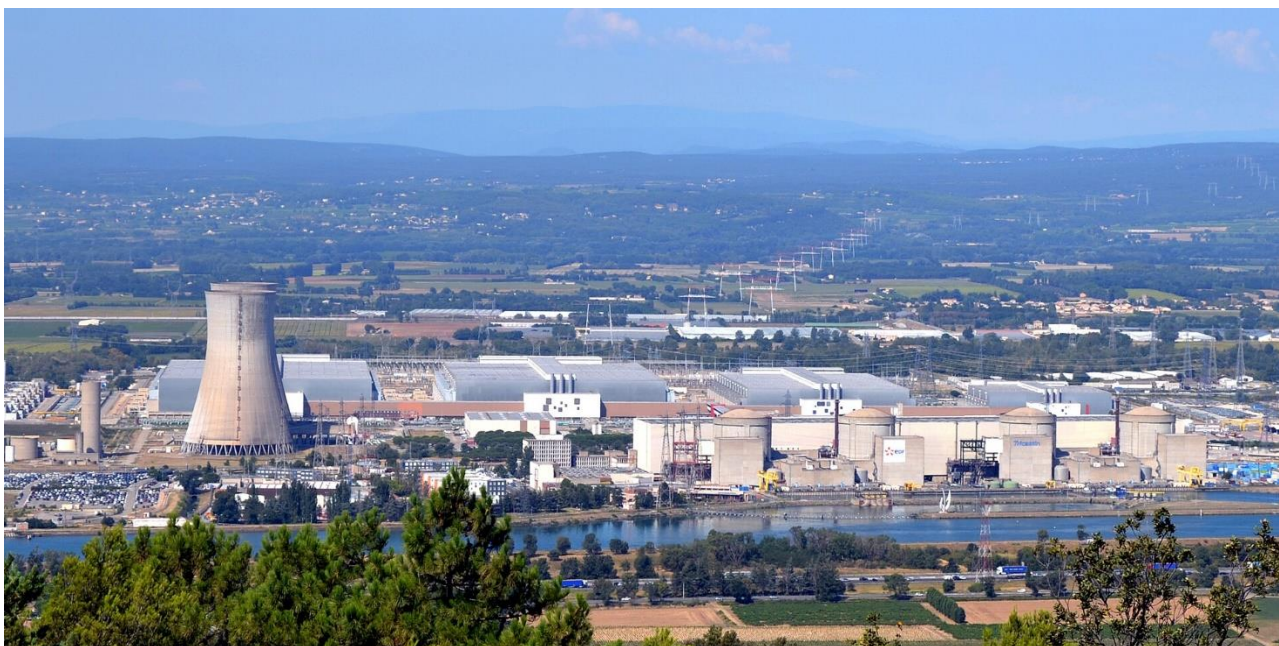
Рис. 2.1.2. АЕС Трікастен (Tricastin), Франція
