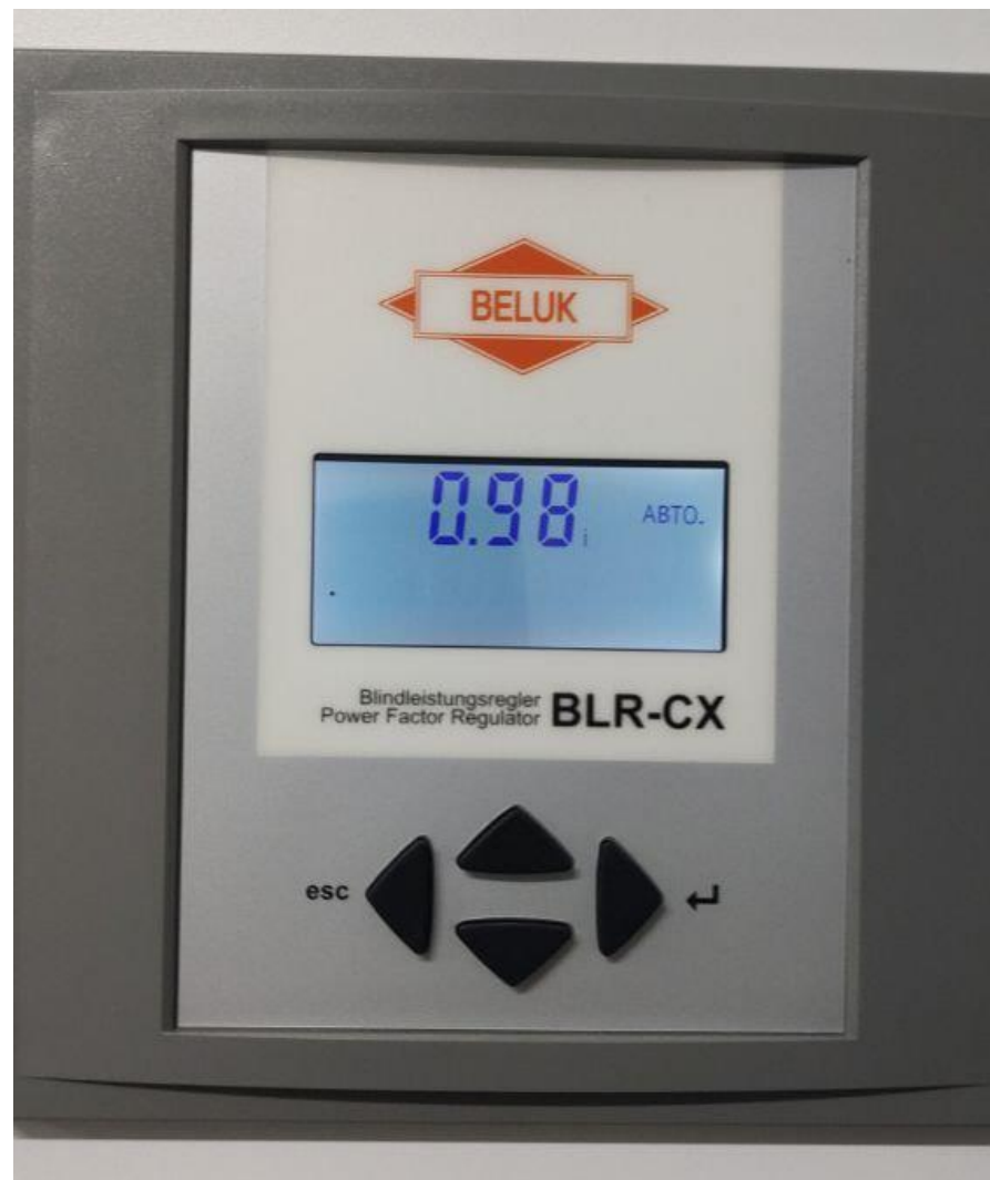
Рисунок 3.2 — Регулятор реактивної потужності Beluk BLR-CX 14R
