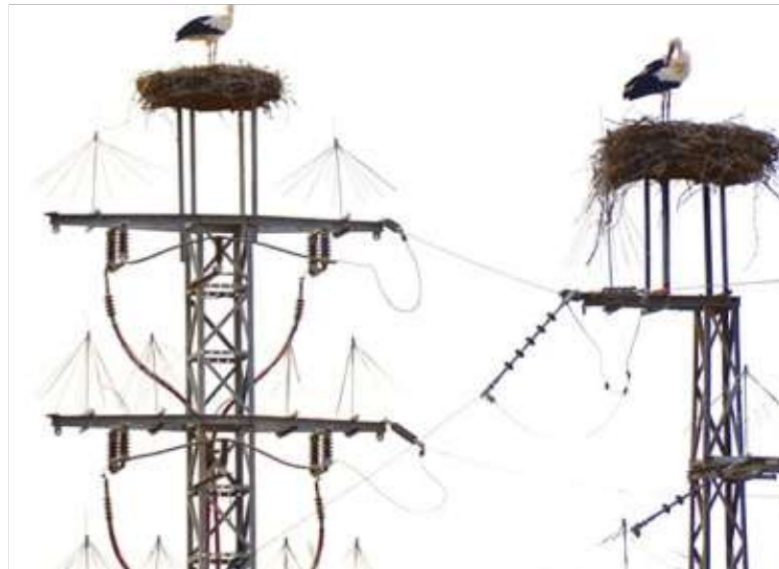
Рисунок 5.1 – Гіздування лелек на опорі повітряної лінії електропередачі
