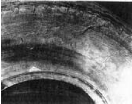
Рисунок 1.20 – Надмірне стирання (спрацювання, знос)
