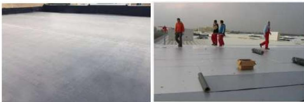
Рис. 3.3. Візуальний вигляд покрівлі покритий мембраною.
