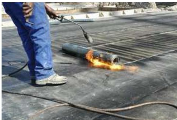
Рис. 6.4. Процес влаштування рулонної покрівлі
