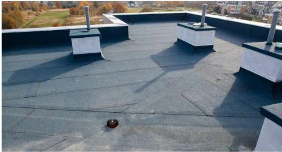
Рис. 6.1. Загальний вигляд плоскої покрівлі.
