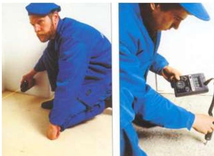
Рис.3.7. Точне визначення розмірів та визначення вологи.
