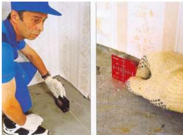
Рис.3.6 .Вимірювання площинності та ухилу основи лазерним нівеліром
