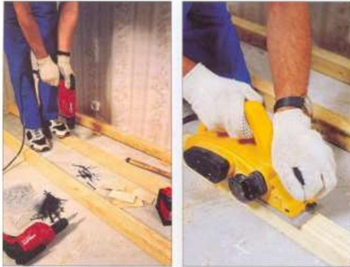
Рис.3.8. Установка та кріплення лаг. Вирівнювання лаг за рівнем
