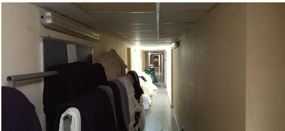
Фото 1.3 Загальний вигляд коридору першого поверху.
