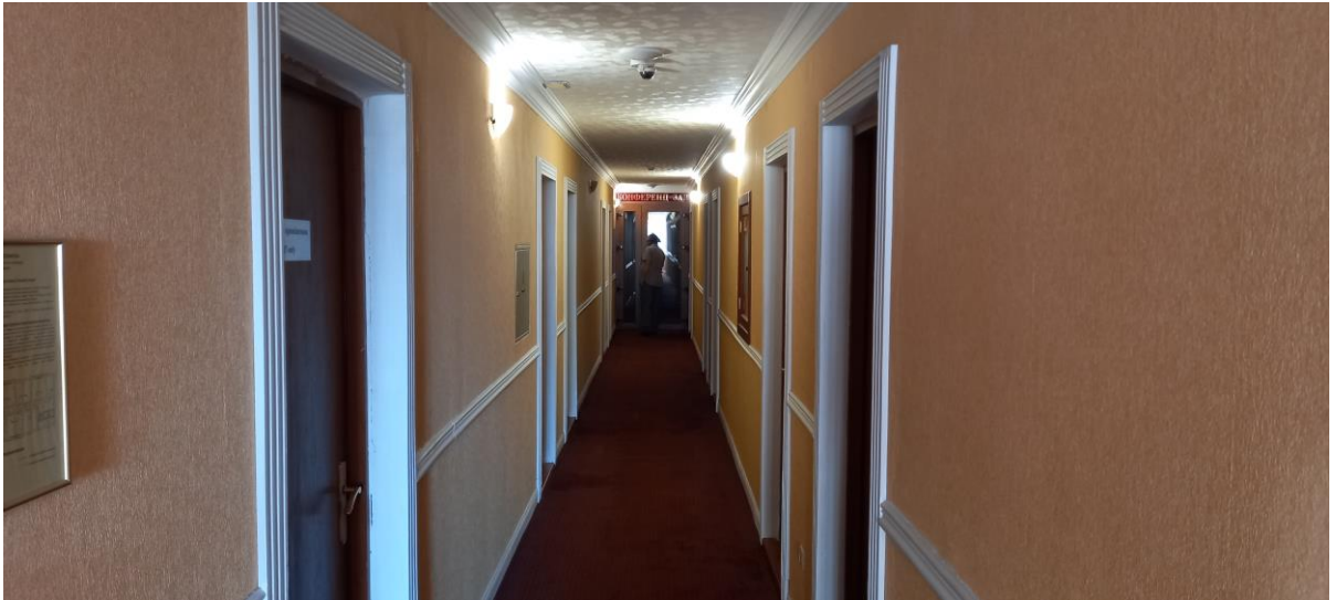
Фото 1.2 Загальний вигляд стїн та стелї коридору другого поверху
