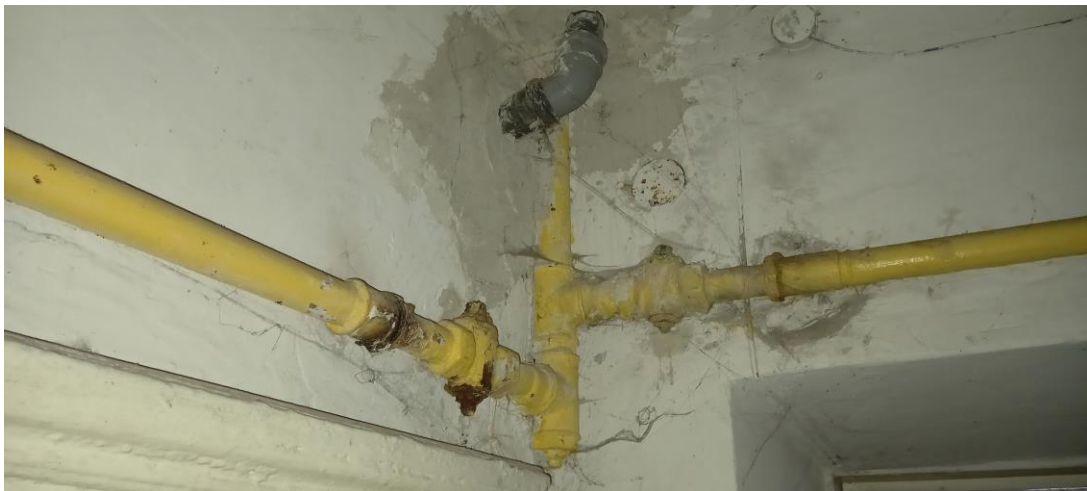
Фото 6.8. Загальний стан інженерних мереж
