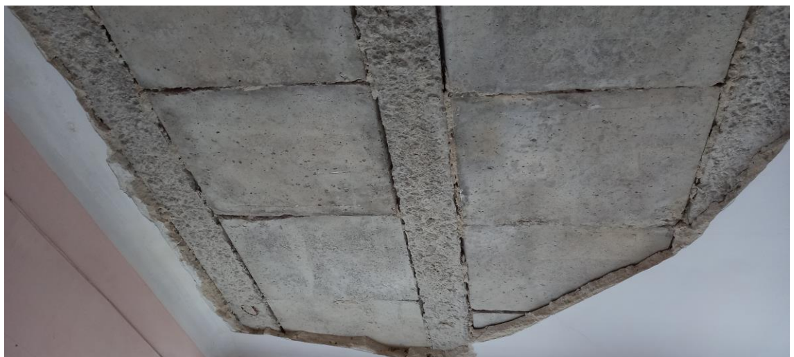
Фото 6.3. Частина заміненого дерев'яного перекриття на збірне залізобетонне між першим та другим поверхом
