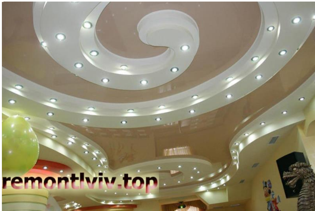
Рис. 3.3 Поєднання гіпсокартону та натяжної стелі [7]
