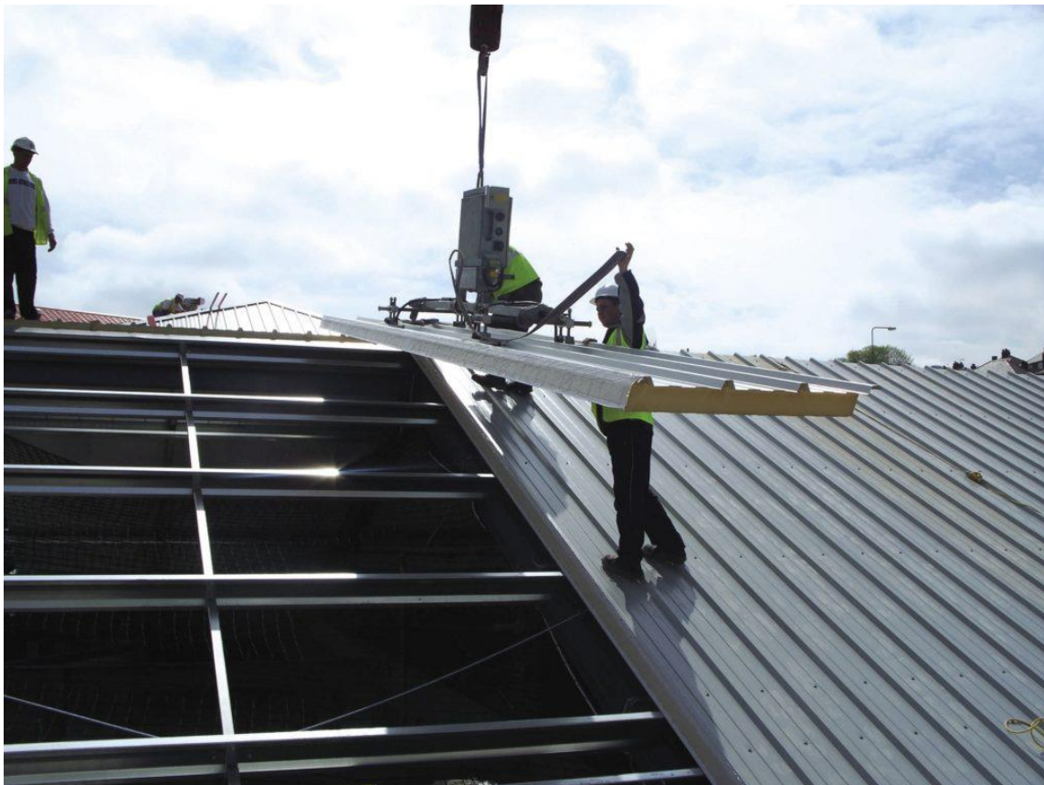
Рис. 6.3 - Монтаж сендвіч панелей
