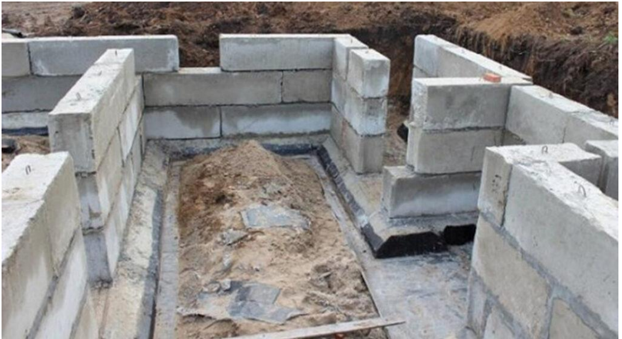
Рис. 5.3 Збірний стрічковий фундамент
