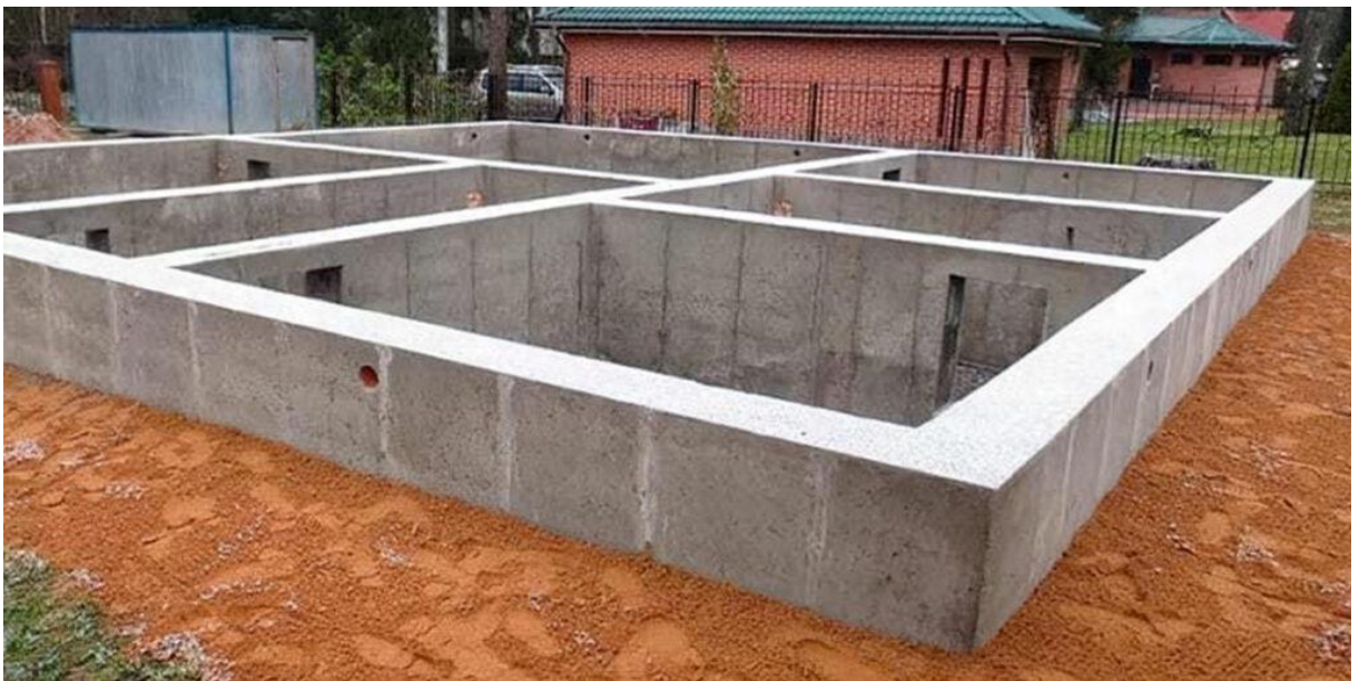
Рис. 5.5 Повнозаглиблений стрічковий фундамент
