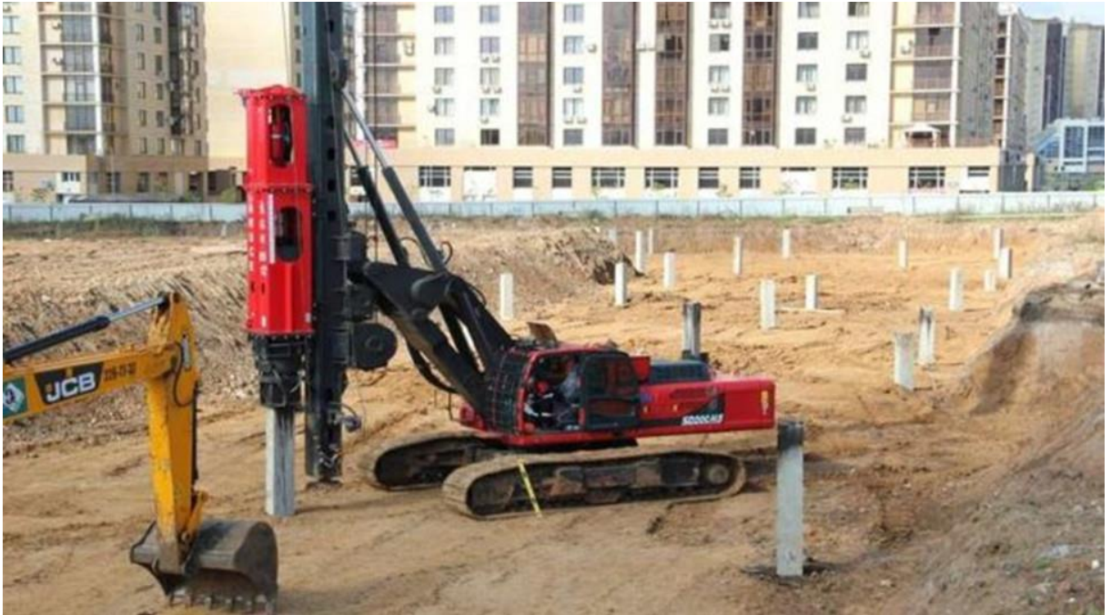
Рис. 5.11 Фундамент на забивних палях
