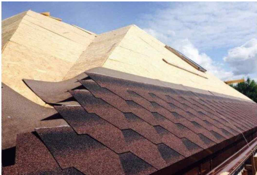
Рисунок 3.5 – Процес монтажу гнучкої покрівлі
