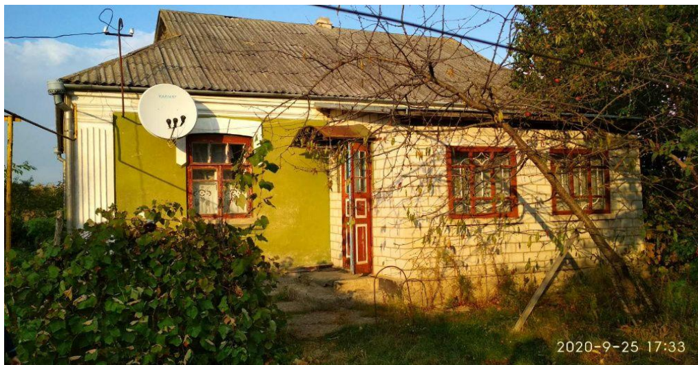
Рисунок 3.1 – Загальний вигляд об'єкта дослідження
