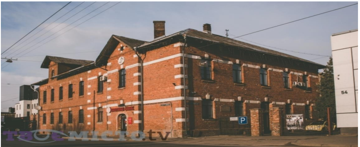
Рисунок 2.11 Фрагмент будівель львівського мясокомбінату
