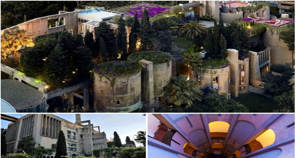
Рисунок 1.6 Приклад використання колишнього цементного заводу в Іспанії
