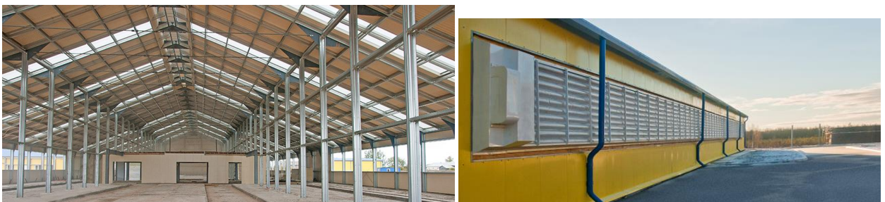
Рис. 29. а) Світлові ліхтарі; б) Сендвіч-панелі та вентиляційні штори
