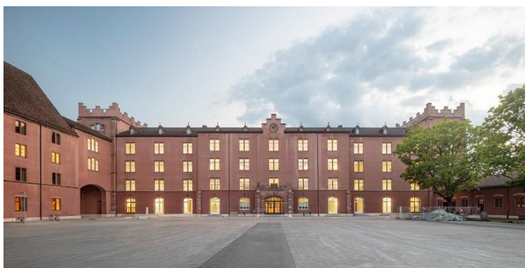
Рис.2.2.5.1. Загальний вигляд колишніх казематів, Базель, Швейцарія
