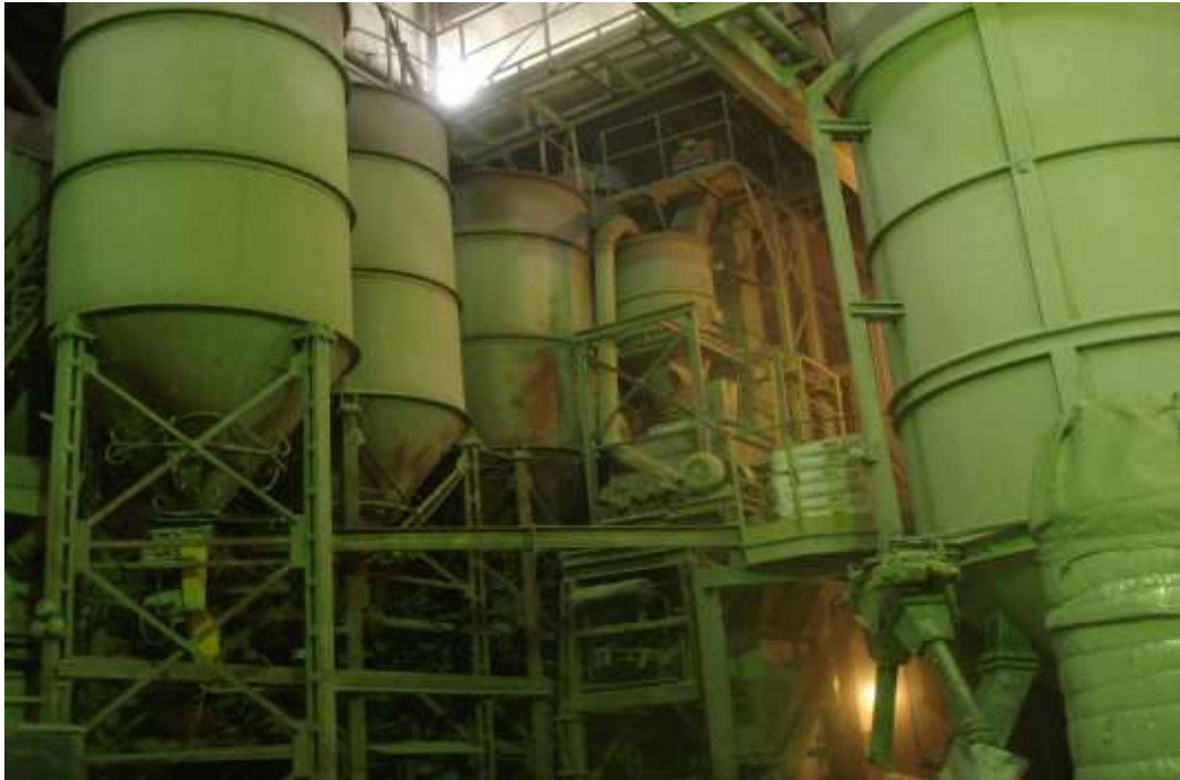
Рис. 3.4 – Приміщення для зберігання цементу
