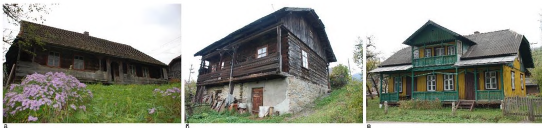
Рис. 2. Житлові будинки компактного планування в с. Козьвій Сколівського району: а) галерея з чотирьох боків; б) галерея з двох боків; в) будинок на дві сім'ї з галереєю, мезоніном і терасою.
