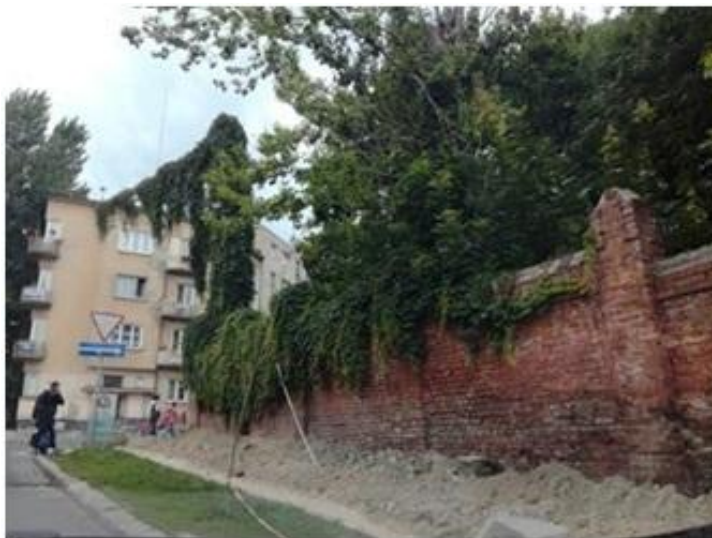
Рис. Г.6.63. Огорожа з незадовільною гідроізоляцією покрита R. quinquefolia (вул. Я. Рапапорта)
