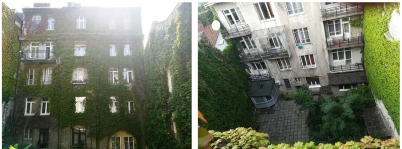
Рис. 4.8. Озеленення закритого дворику на вул. Левицького
