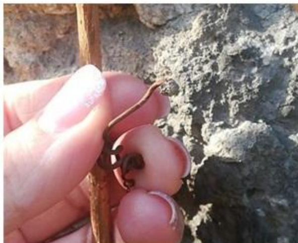
Рис. Г.6.64. Відривання фрагменту штукатурки (вул. Кирила і Мефодія, пл. Митна)
