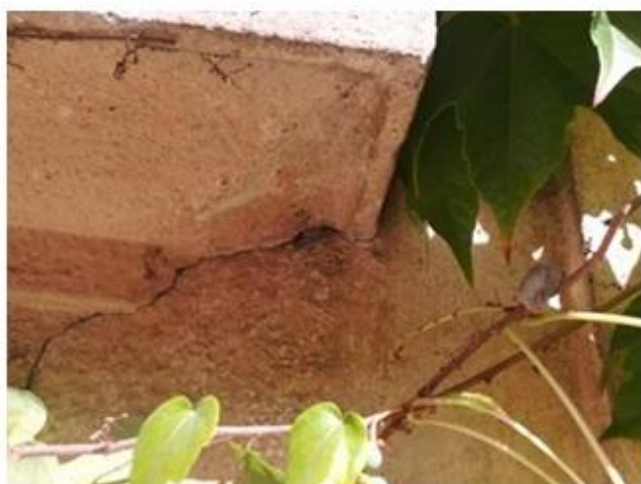
Рис. Г.6.64. Відривання фрагменту штукатурки (вул. Кирила і Мефодія, пл. Митна)
