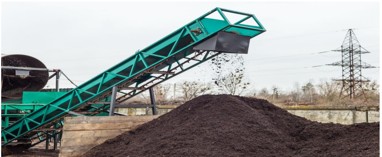
Рис. 2.5. Просіяний компост на станції компостування у м. Львові
