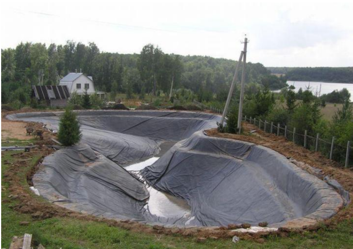
Рис. 3.20. Приклад облаштування дна штучної водойми з метою мінімізації втрат води
