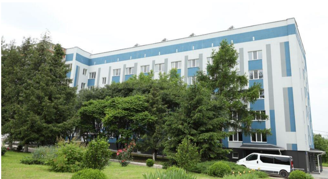
Рис. 2.27. Відремонтована будівля для забезпечення термінового житла для ВПО у Золочеві, Україна
