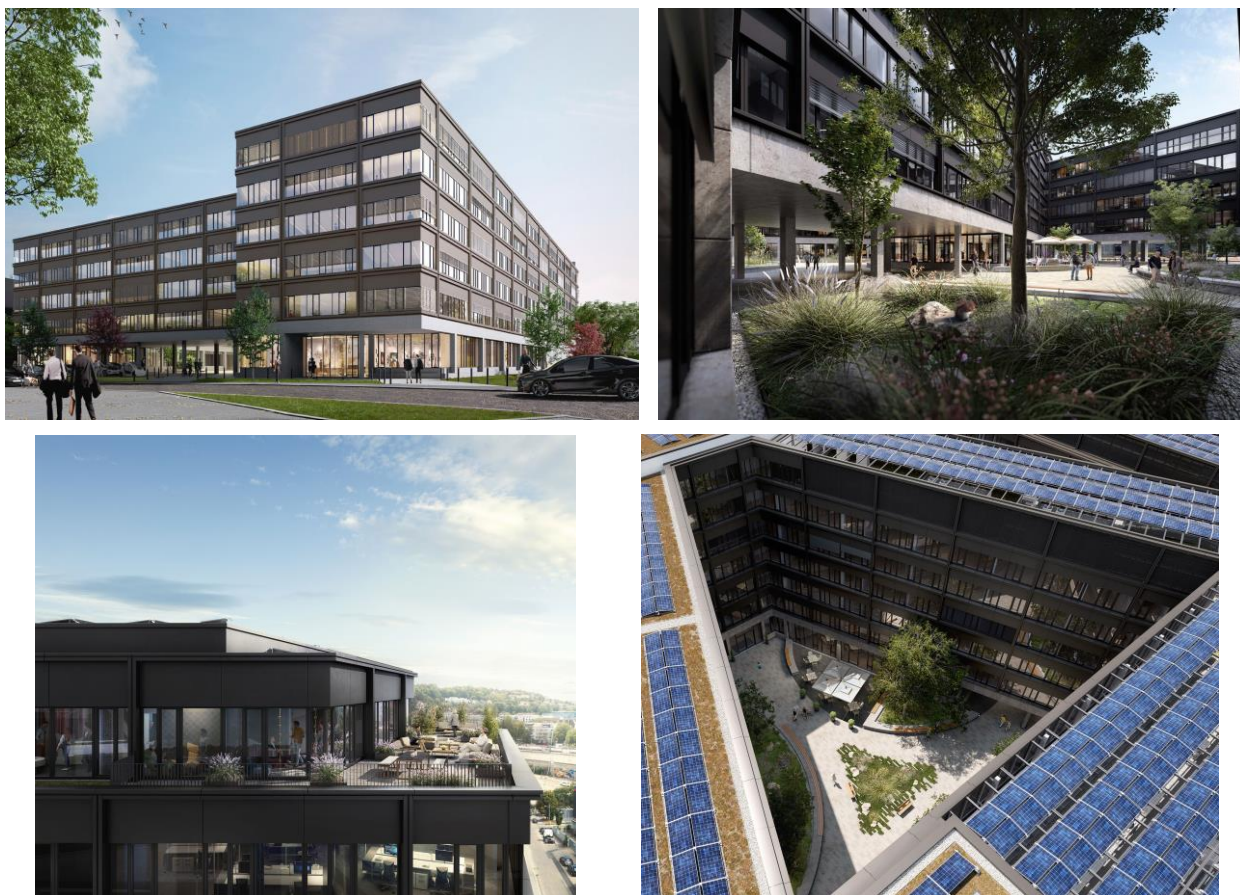
Рис. 2.18. Технологічний центр Штутгарт-Фойербах облаштований сонячними панелями по даху
