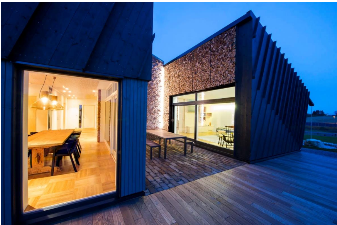
Рис. 2.1. Норвегія – енергонульові «плюс-будинки» (ZEB Pilot House, Ларвік). Фото: Паал-Андре Швіталь [25]
