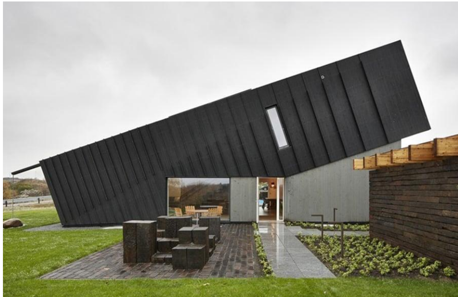
Рис. 2.5. Пілотний будинок ZEB від Snøhetta: похилий фасад [20]
