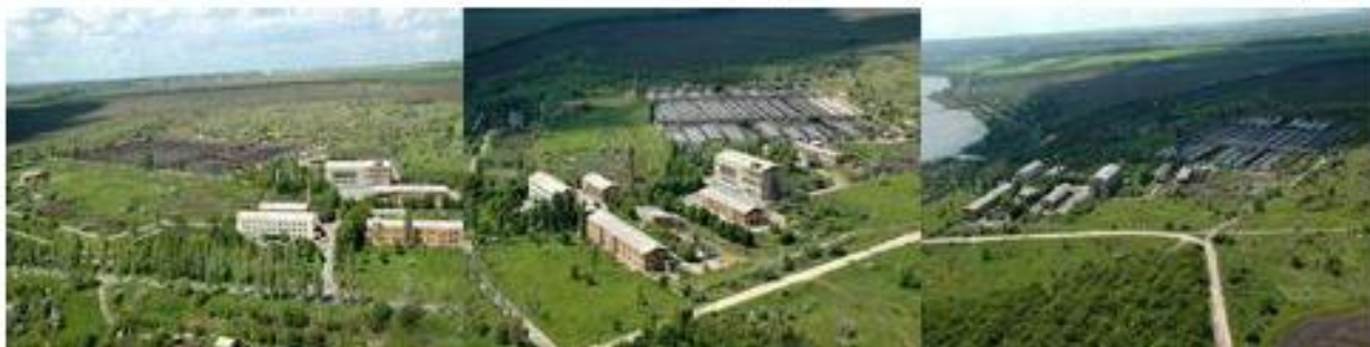
Рисунок 3.8 – Центральна станція аерації м. Дніпро
