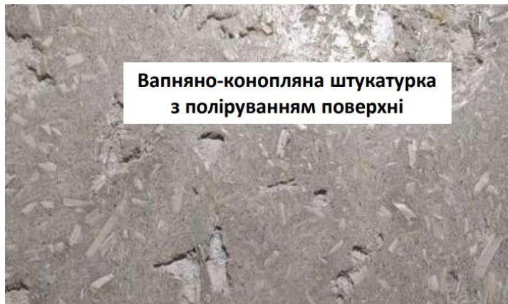
Рисунок 12 – Вапняно-конопляна штукатурка з поліруванням поверхні
