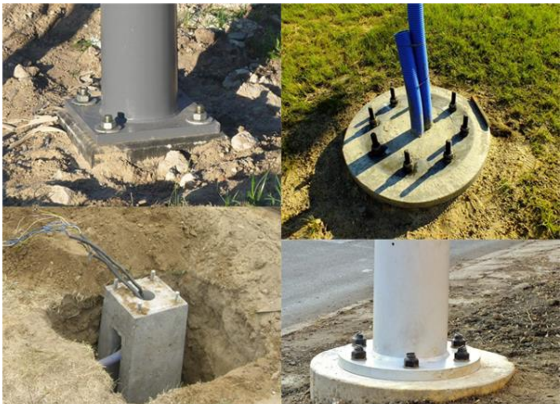
Рисунок 15 - Анкерний закладний фундамент
