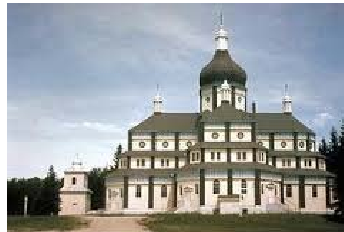
Рис. 3.2.3. Церква Покрови Пресвятої Богородиці в Мавnten Ровд, Манітоба. (Архітектор о. Пилип Ру) [91]
