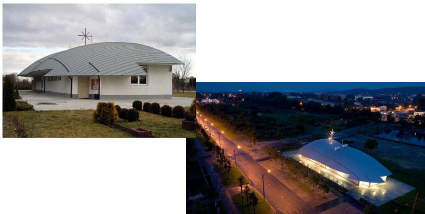
Рис. 2.1.1; 2.1.2. Греко-католицька церква на вул. Лінкольна у Львові. Загальний вигляд [124]. Вигляд на фоні нічного міста [127]. (Автори Рибенчук М. М., Рибенчук О. Т., Медвідь Л. М.)
